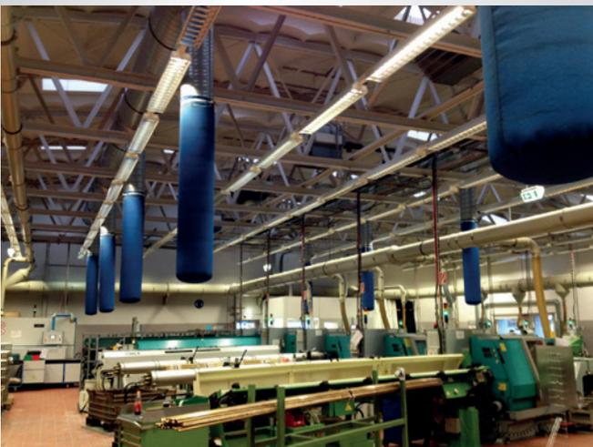
Zuluftverteilung über vertikal angeordnete, Textil-Verdrängungsluftauslässe in einem metallverarbeitenden Betrieb.
