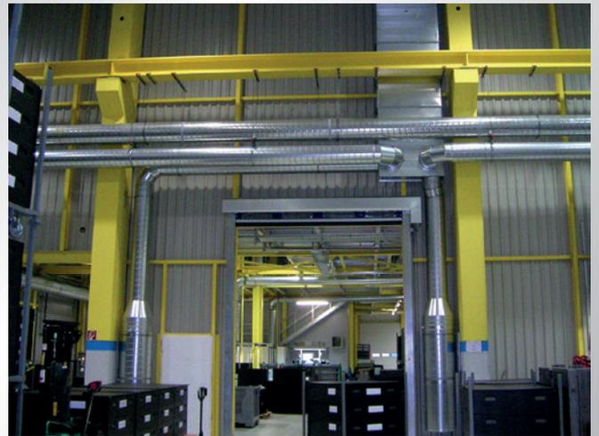
Beispiel für eine definierte Zulufteinbringung über Quellluftauslässe zur Erzeugung einer so genannten "Schichtenströmung".
