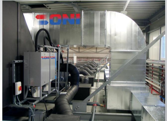
Luftverteilung für einen Reinraum der Klasse ISO 8 (100.000) mit vorgeschalteter Dampfbefeuchtung und Volumenstromregelung.
