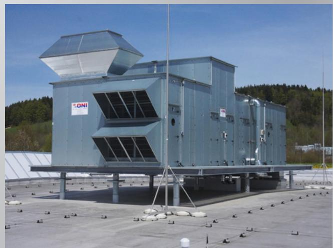
Auf dem Hallendach eines Industriebetriebes aufgeständertes, zentrales Lüftungsgerät zur Versorgung von Produktionsräumen.
