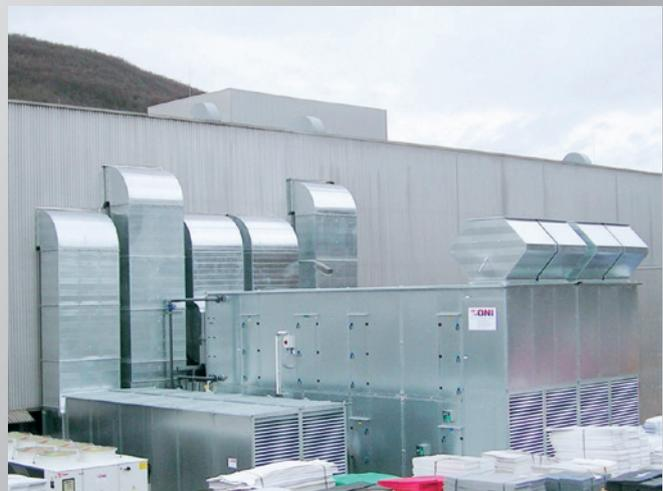
Energieoptimierte, zentrale Lüftungsanlage mit Wärmerückgewinnung, zur Nutzung kostenloser Produktionsabwärme bei einem Kunststoffverarbeiter.
