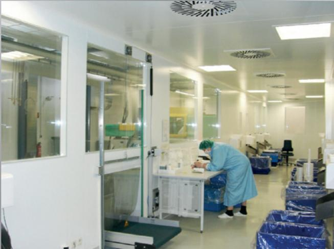
Blick in einen Reinraum der Klasse ISO 7 (10.000), der einer Raumfertigung für medizintechnische Produkte nachgelagert ist.
