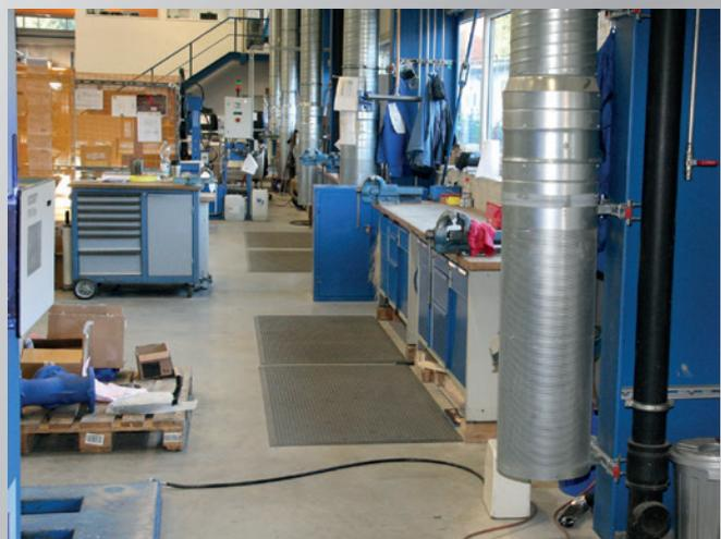
Zuluftverteilung über Verdrängungsluftauslässe in einem metallverarbeitenden Betrieb.
