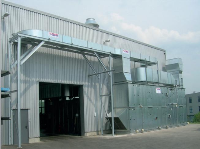
Besonders energieeffiziente, zentrale Lüftungsanlage, die Abwärme aus der Prozesskühlung für die Beheizung nutzt.
