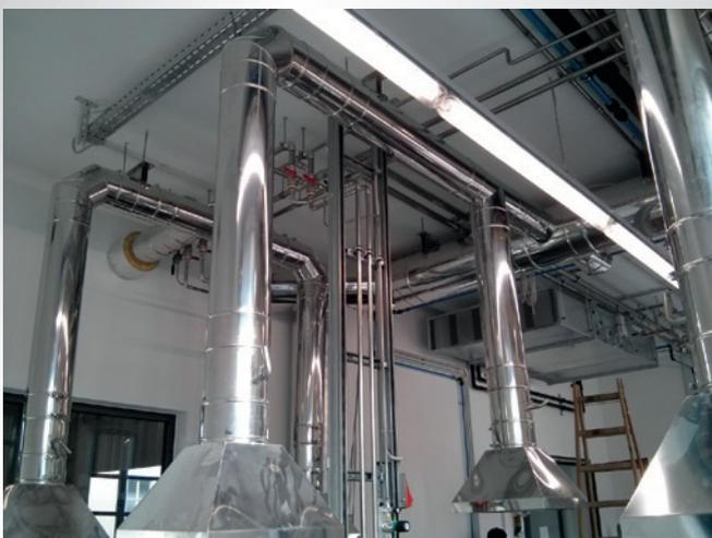
Absaugsysteme an Glüh- und Sinteröfen. Nutzung der Abwärme für die Frischluftherwärmung über eine Wärmerückgewinnung.
