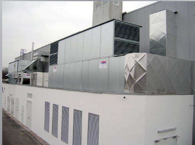
Auf dem Dach eines Kunststoff verarbeitenden Betriebes installiertes Zentrallüftungsgerät, das den Produktionsbereich mit konditionierter Luft versorgt.
