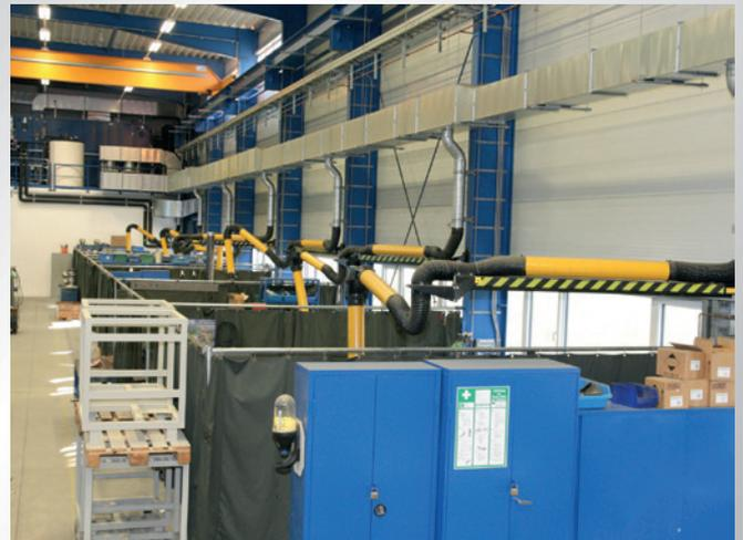
Flexible-Absaugsysteme an Schweißplätzen. Nutzung der Abwärme für die Frischluftherwärmung über eine Wärmerückgewinnung.
