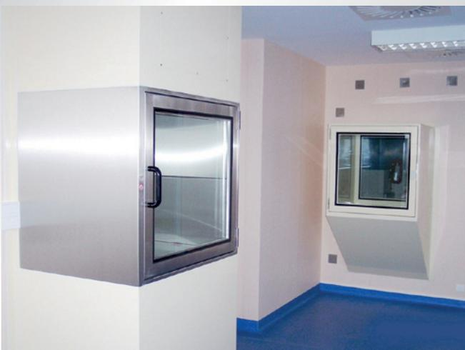
Luft-Schleusen für eine Reinraumfertigung in einem Kunststoff verarbeitenden Betrieb mit Schwerpunkt Medizintechnik.
