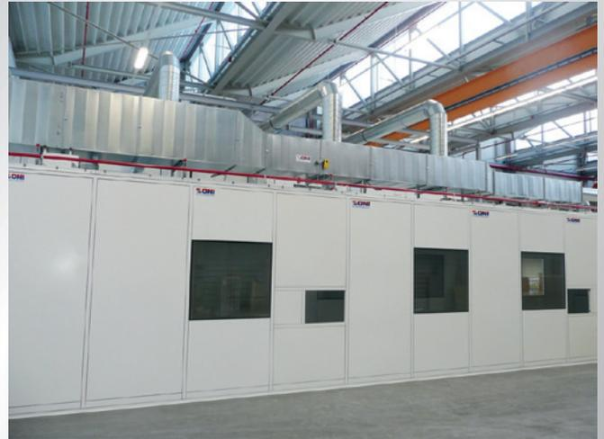
Reinraum Klasse ISO 7 (10.000), der über ein zentrales Lüftungsgerät und nachgeschaltete Schwebstoff-Filtereinheiten versorgt wird.
