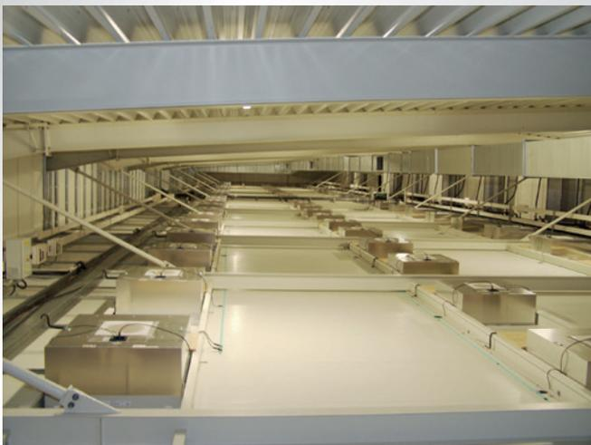
Blick in ein Plenum mit FilterFanUnits, die einen darunterliegenden Reinraum flächendeckend mit konditionierter Luft versorgen.
