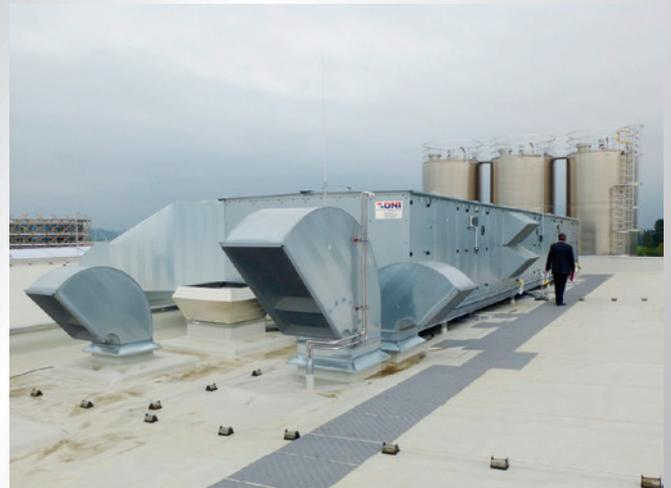
Außenansicht einer großen lufttechnischen Anlage mit Wärmerückgewinnung bei einem Kunststoff verarbeitenden Betrieb.
