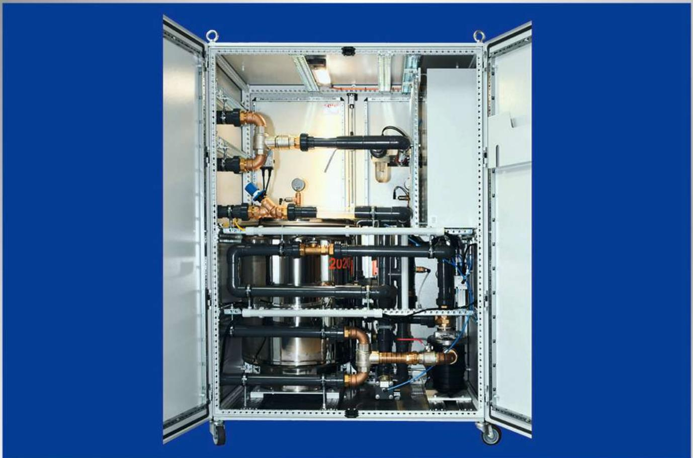
ONI-AquaClean-CT Anlage Rückseitenansicht mit Blick auf Filter und Verrohrung
