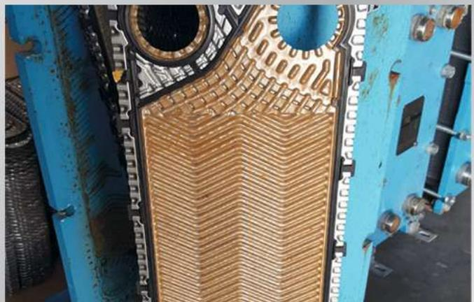
Beispiele für Beläge auf Rohrrinnenwand und Wärmeaustauscherflächen aus Kalk, Korrosionsprodukten, Schmutz und Biologie.
