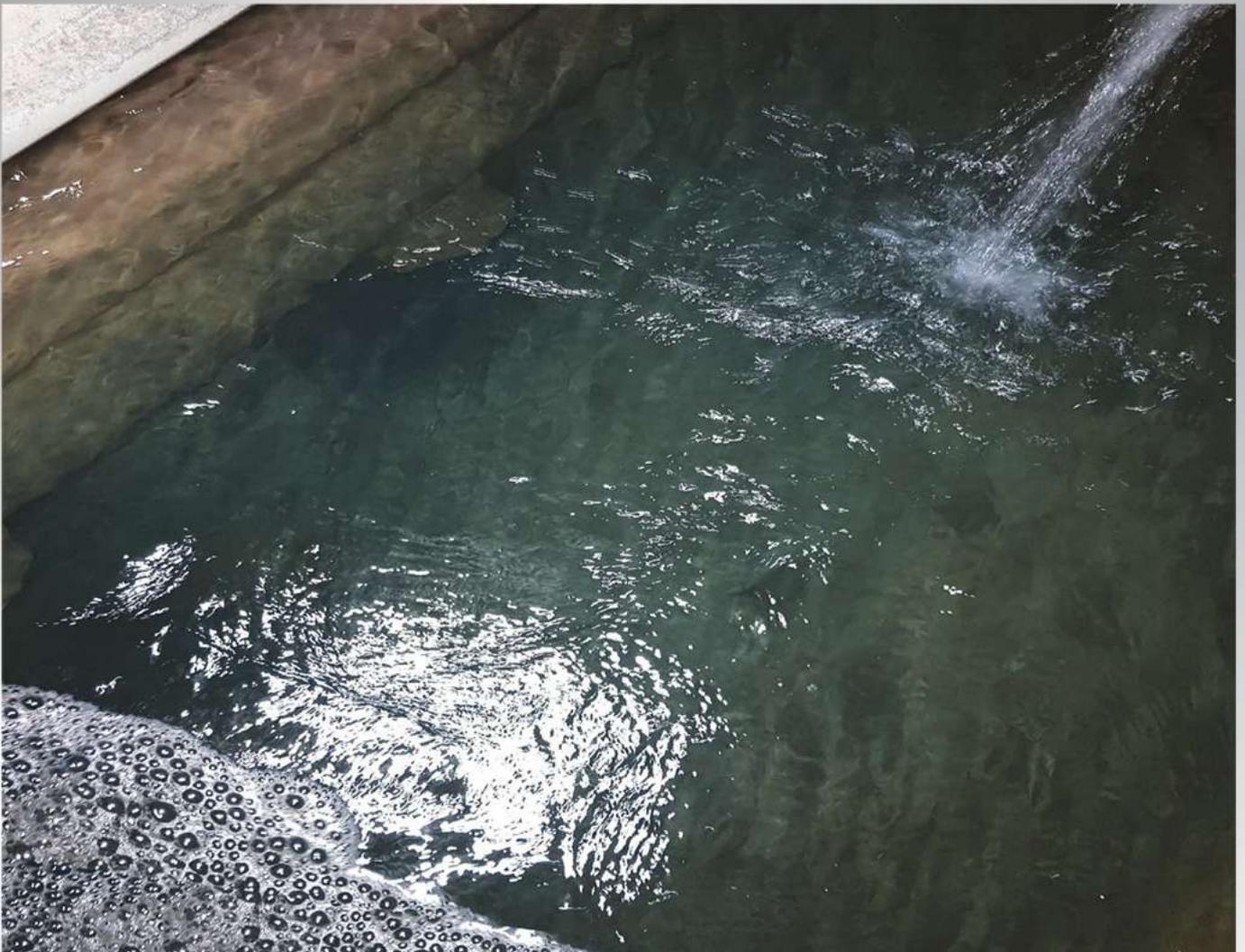
Blick in den Tank der Kühlwasserversorgungsanlage, die zur Rückkühlung einen Kühlturm nutzt. Nach einem dreiwöchigen Einsatz einer ONI-AquaClean-CT Anlage ist das Wasser nahezu glasklar und die Hygieneprüfung weist einen Wert von weniger als 100 KbE aus.
