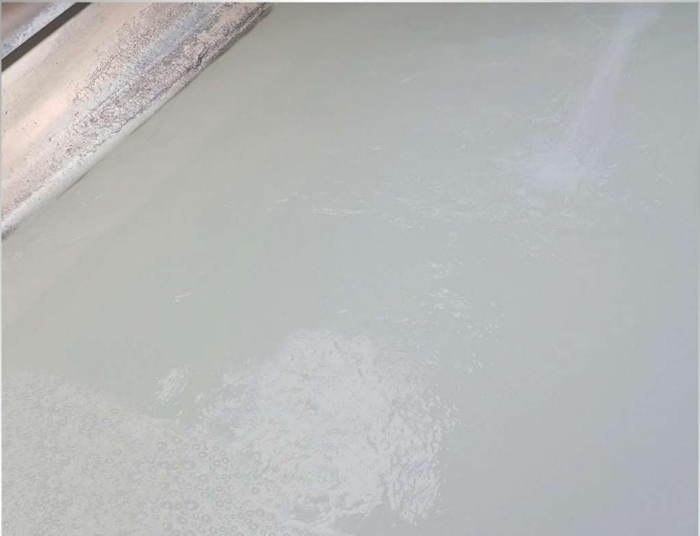
Blick in den Tank einer Kühlwasserversorgungsanlage, die zur Rückkühlung einen Kühlturm nutzt. Das Wasser hat eine hohe Trübung durch dispergierende Feststoffpartikel sowie eine starke biologische Belastung.
