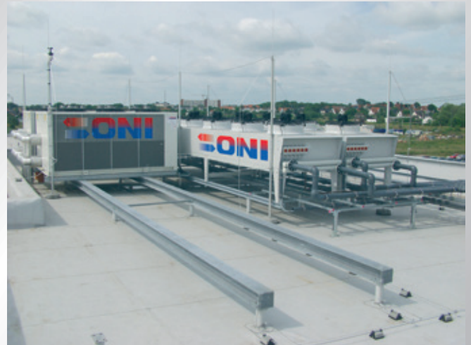
Zweikreis-Kühlanlagentechnik mit Winterentlastung zur Stromeinsparung an Kältemaschinen bis zu 80 %
