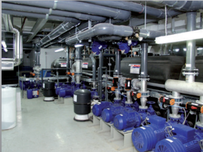
Energetisch optimierte Kühlanlage zur Versorgung von Produktionsmaschinen sowie Klima- und Lüftungsanlagen. Mit Wärmerückgewinnung zur Nutzung kostenloser Abwärme und einer glykolfreien Winterentlastung zur Stromverbrauchsreduzierung der Kältemaschinen Energy-optimized cooling system for feeding production machines as well as air-conditioning and ventilation systems. With heat recovery for using cost-free waste heat and a non-glycol winter relief for reducing the power consumption of chillers
