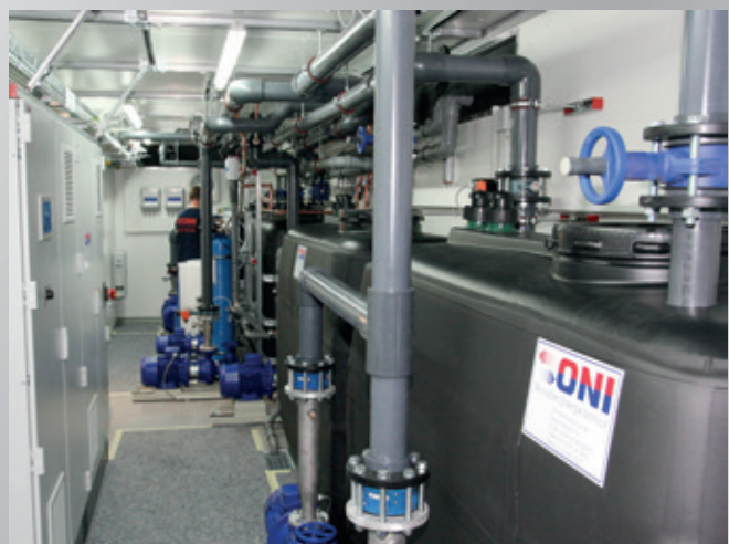
Blick in einen Teil einer modularen Kühlenergiezentrale mit Pumpen-Tankeinheit
