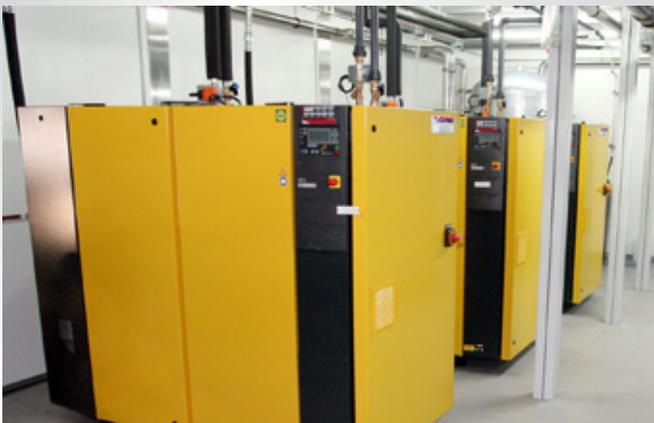
Druckluftanlage mit Wärmerückgewinnung in einer modularen ONI-Energiezentrale.
