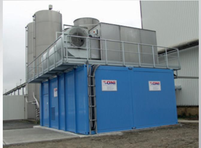
Container-Kühlanlage mit Zellenkühlturm und Systemtrennung über Wärmeaustauscher
