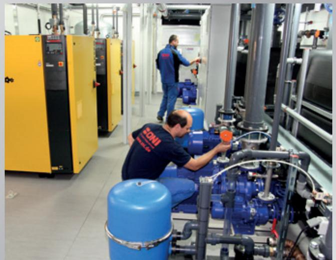
Blick in eine energieoptimierte, modulare Energiezentrale in der Endmontagephase im ONI-Werk in Lindlar.
